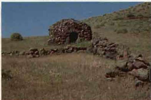
Esta casa redonda con techo en cúpula construida con piedras junto al volcán del Melosal el siglo pasado constituye uno de los últimos vestigios de la actividad pastoril en el paraje, y también un posadero socorrido para la avifauna local.
