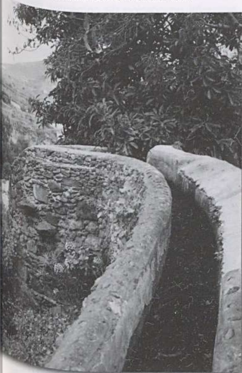
Acequia de mampostería ordinaria y cubo de molino de agua. Valle de los Nueves. Gran Canaria
