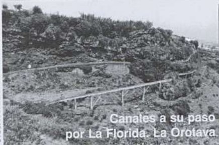
El canal sale del mismo frente de la galería, teniendo que salvar grandes desniveles en su recorrido
