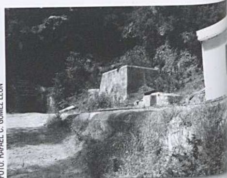
En ocasiones el canal sale de la galería por debajo de «la repisa» para luego coger el nivel adecuado. Galería «El Portillo»
