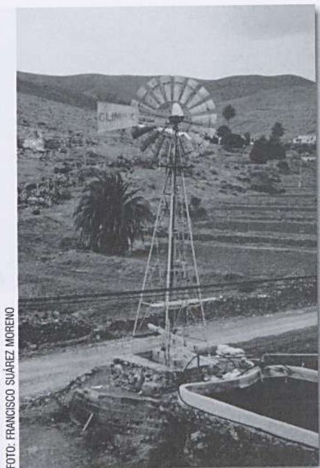
Conjunto hidráulico tradicional de Fuerteventura: pozo, molino y tanque
