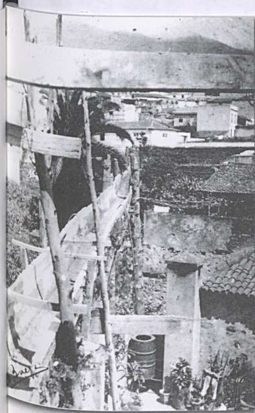
Canal de madera para la conducción de agua para los molinos. La Orotava, Tenerife
