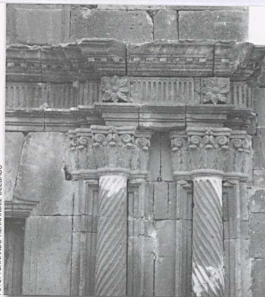
Detalle de la fachada de la casa de los marqueses de Adeje, Garachico. Destacan los motivos vegetales, junto a los surcos helicoidales de las columnas, y el almohadillado que rodea a los marcos de los vanos (huecos)
