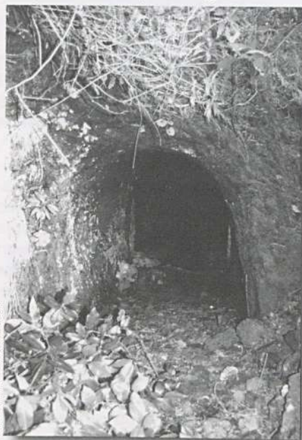
El trabajo «a brazo» no permitía perforar grandes dimensiones. Galería «Las Peñas», Pinolere
