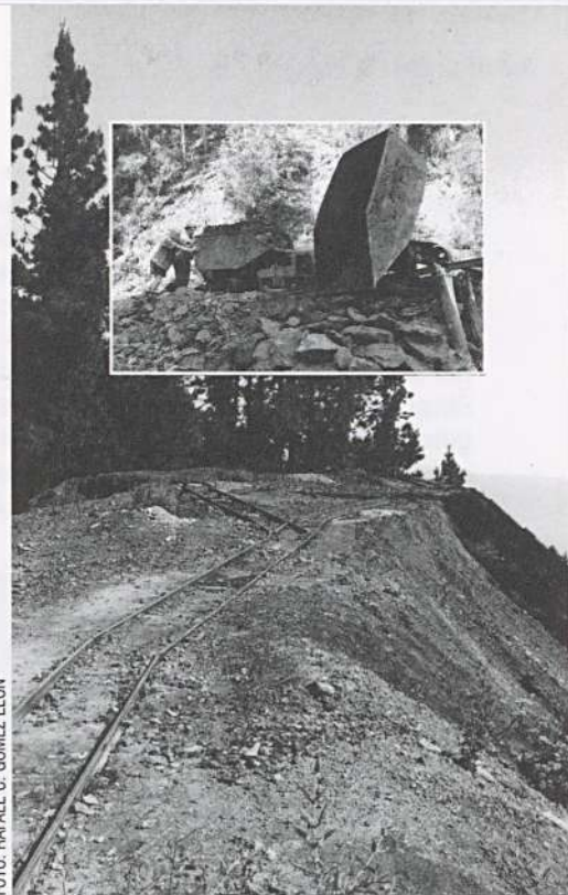
«La planada» con los ramales para distribuir los materiales de «la pega»
