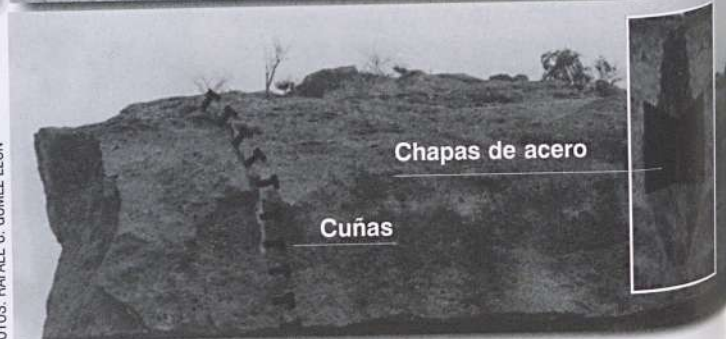
Detalle, simulado, de como se va fraccionando una tumba para conseguir los espesores deseados. En el recuadro, canal con dos chapas a los bordes donde se introduce la cuña y se baña con agua para compactar el polvillo.
