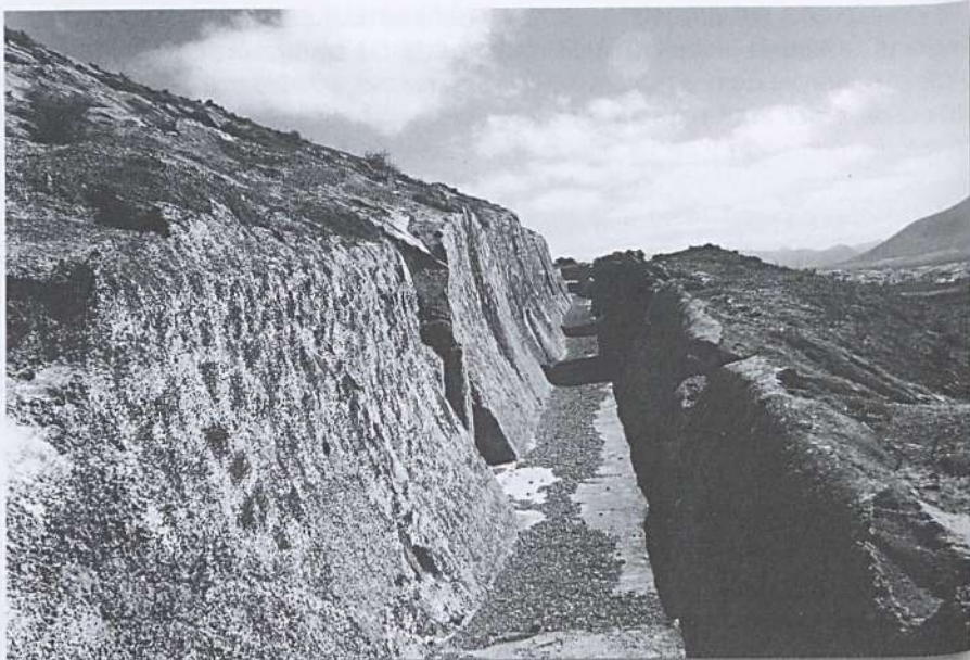
Canalización de la acogida en las laderas de la montaña de Guatisea. En el interior de la montaña se construyeron los depósitos, de donde trasladar el agua hasta Arrecife, sin que llegaran a funcionar.
