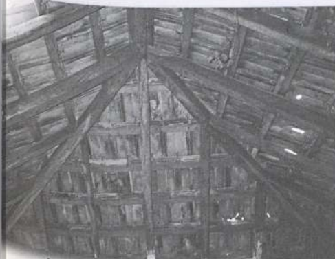
Interior de cubierta con teja plana o teja francesa
