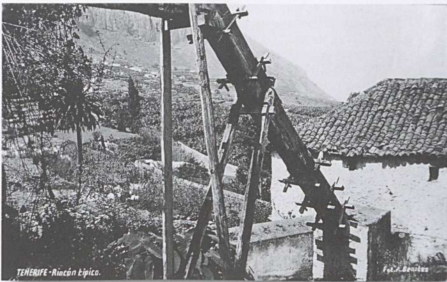
Acequia de madera para la conducción de agua en la isla de Tenerife.
