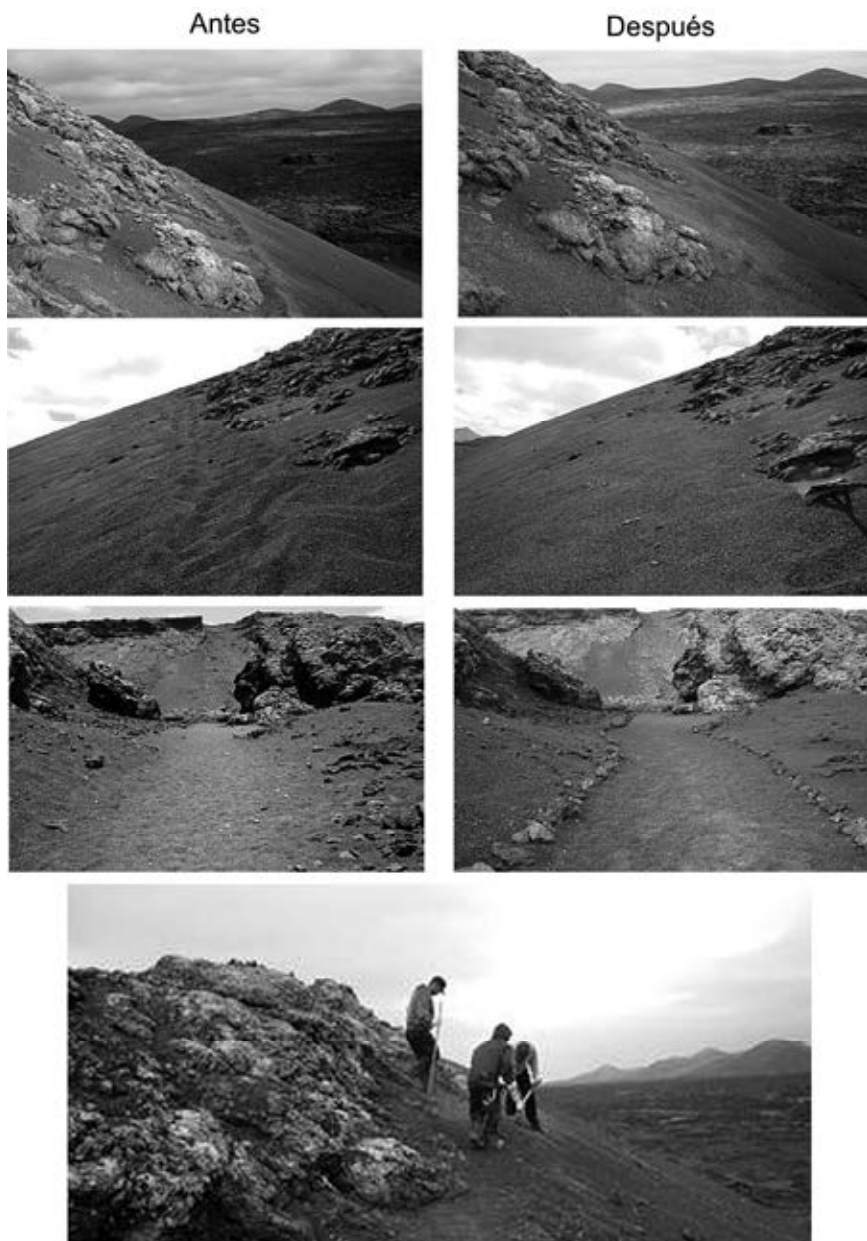
Fig. 12. Labores de geoconservación desarrolladas en la zona de Caldera del Cuervo. Utilizando en gran parte trabajos a mano se restableció la forma original de sus laderas y se delimitó un solo camino, eliminándose en la medida de lo posible las huellas y veredas incontroladas existentes.
