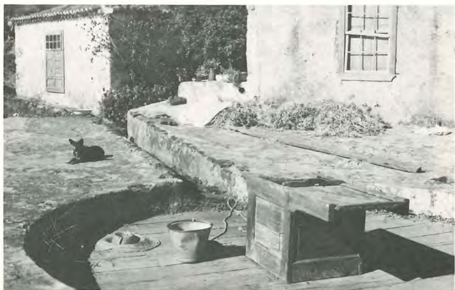
Aljibe de sección circular (Los Llanos de Aridane, La Palma).
