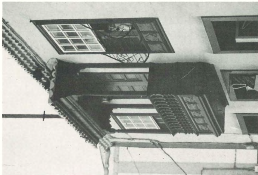
Balcón con tejadillo y con antepecho de tableros y balaustres; éstos sobre fondo de celosía (Santa Cruz de la Palma).
