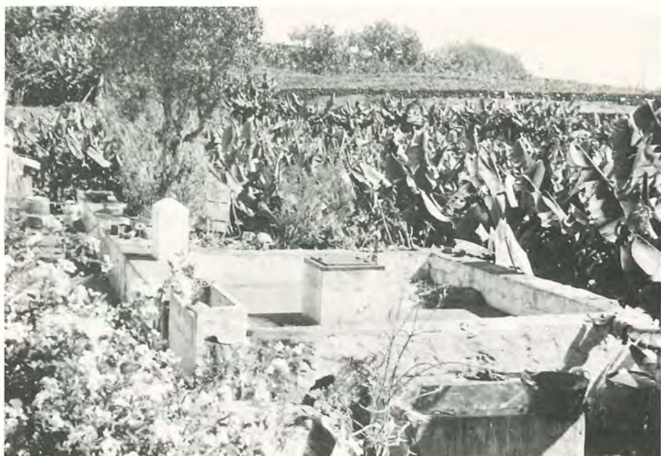
Aljibe de sección rectangular (Breña Alta, La Palma).
