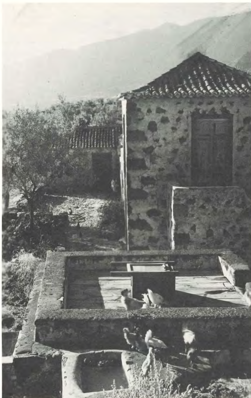
Aljibe de sección rectangular perteneciente a una casa con escalera exterior (Los Llanos de Aridane. La Palma). (Foto Quintero.)
