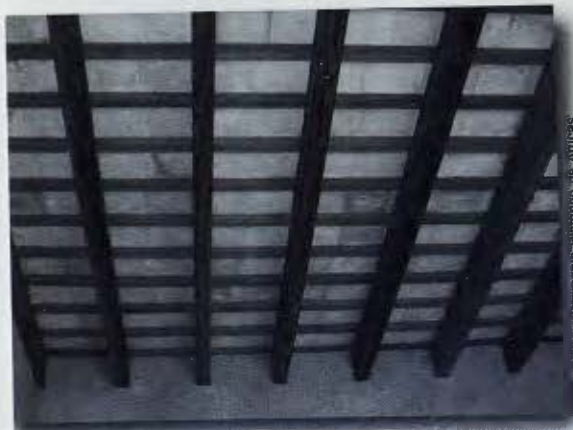
Centro de Interpretación del Labrante. Interior del edificio rehabilitado.
