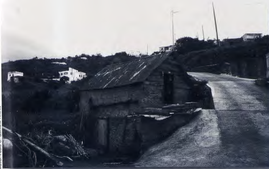
En este ejemplo la casa se encuentra situada sobre una habitación de iguales dimensiones construida de bloques y argamasa (Lomo de Garachíco).
