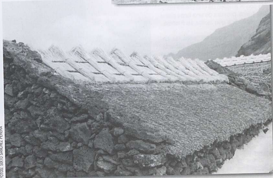
Arriba, prototipo de casa pajiza herreña. A la derecha, reparación parcial de los caballetes
