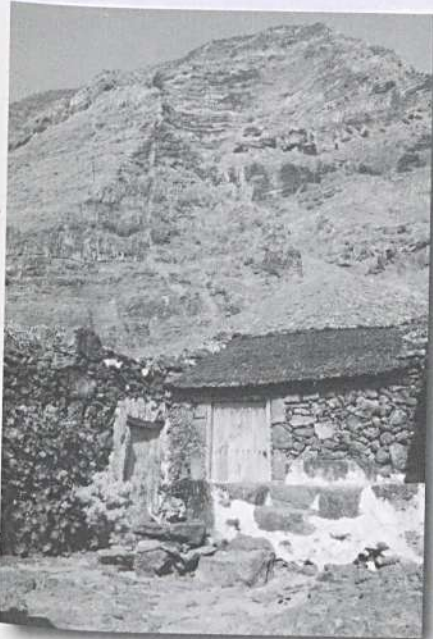
Casa en Guinea y Fuga de Gorreta al fondo
