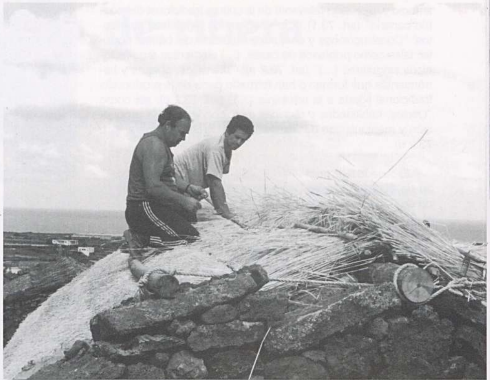
Arriba, primer paso en la confección del caballete. A la izquierda, detalle del acabado del caballete. Abajo, colocando los parapetos
