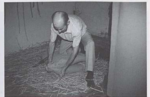
"Antes de levantar el armazón del banco hay que darle unos golpitos para que la paja vaya a su sitio".
